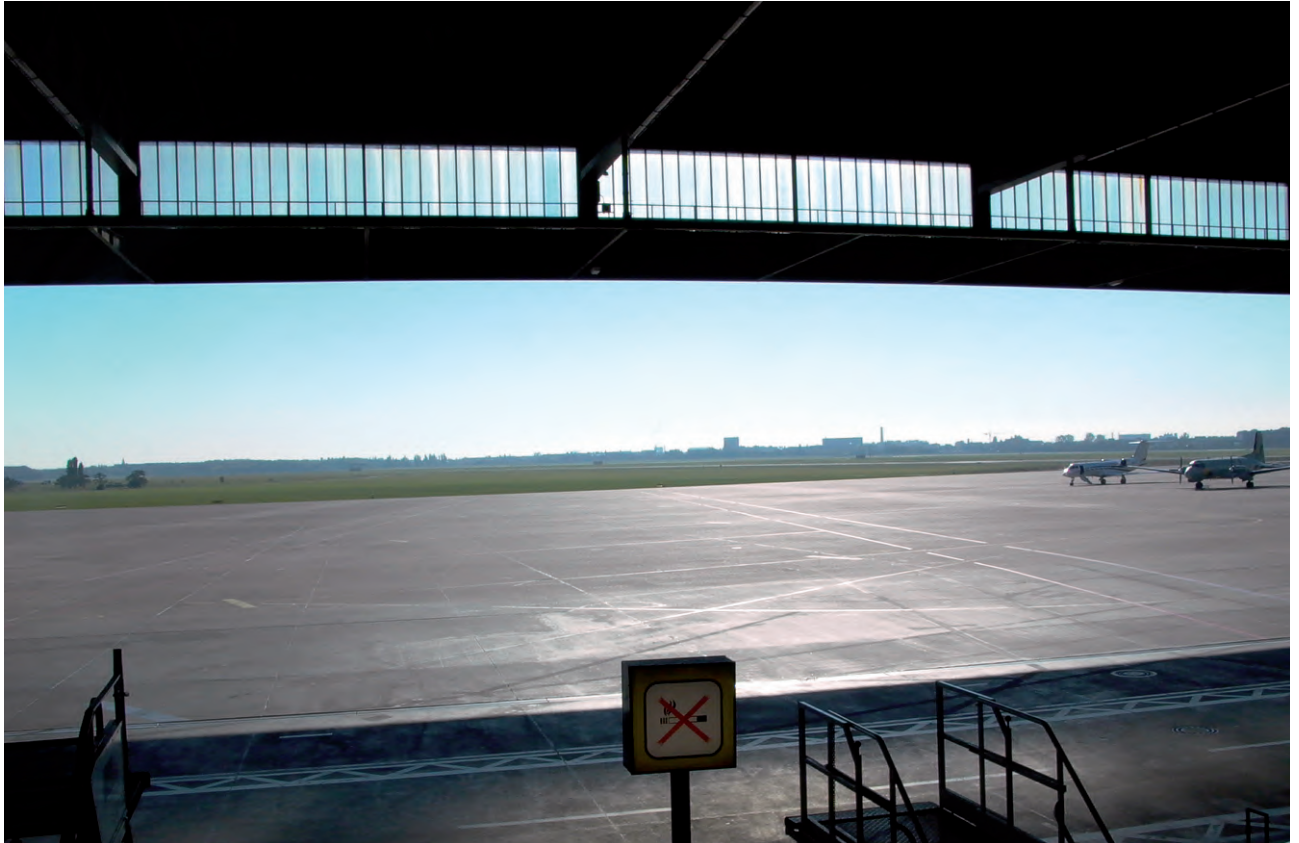
Blick ins Offene _Flughafen Tempelhof _ursprünglich geplant mit einer großen Tribüne auf dem Dach | 1942
